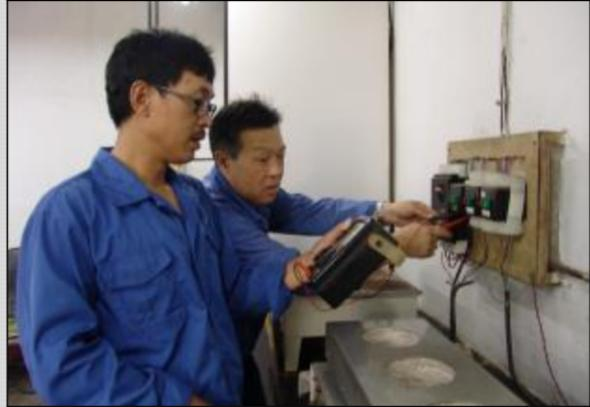
近日，技术中心化验分析室检修人员对变压器、断路器、互感器等用电设备进行全面排查，掌握冷却设施、测温装置运行状况，并对设备进行防污、清洁处理。图为技术中心化验分析室电工正在检查空气开关。
